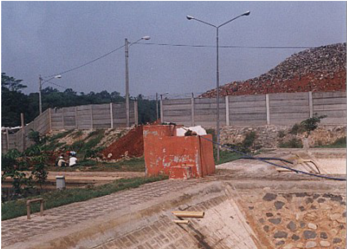
Gambar 3. Foto timbunan sampah pada Zone 2 tahun 2002 yang sebagian telah memasuki zone pengolahan limbah.
